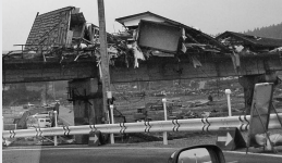
鉄橋の上に乗り上げた住宅(南三陸町付近)
